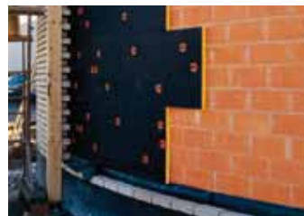
Metselen van binnenmuur. Daarna isolatie aanbrengen. Tot slot gevelsteen optrekken.
