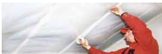
Luchtdicht maken door het tapen van het dampscherm.
