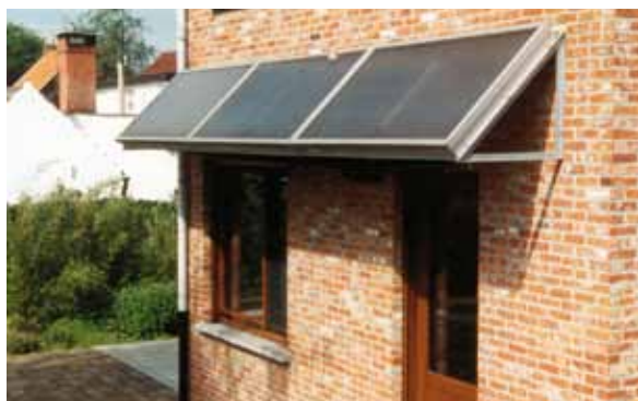
Zonnepanelen voor de productie van warm water.
