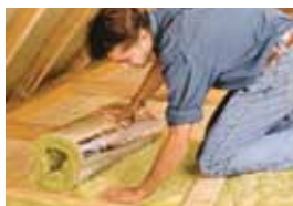
Isolatie van de zoldervloer met minerale wol.
