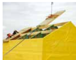
Isolatie van hellend dak met isolerende dakelementen.
