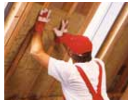
Isolatie van hellend dak met minerale wol.
