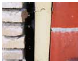
Isolatie van spouwmuur met PUR.
